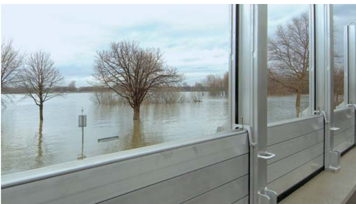
Aufgebaute Hochwasserschutzwand/Bauelemente
