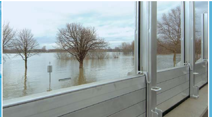
Aufgebaute Hochwasserschutzwand/Bauelemente
