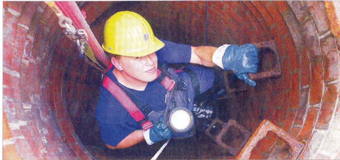
In die Unterwelt steigen die Fachkräfte hinab, wenn sie die Abwasserrohre mit modernen Geräten untersuchen. (Foto: dpa)
