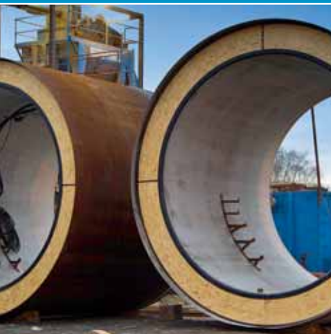
Baustelle Geestemünder Straße
