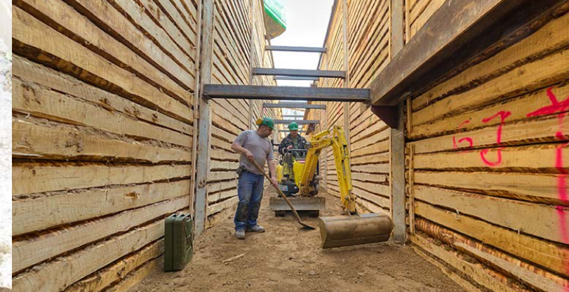
Baugrube aus Trägerbohlwandverbau mit Holzaustrichtung
