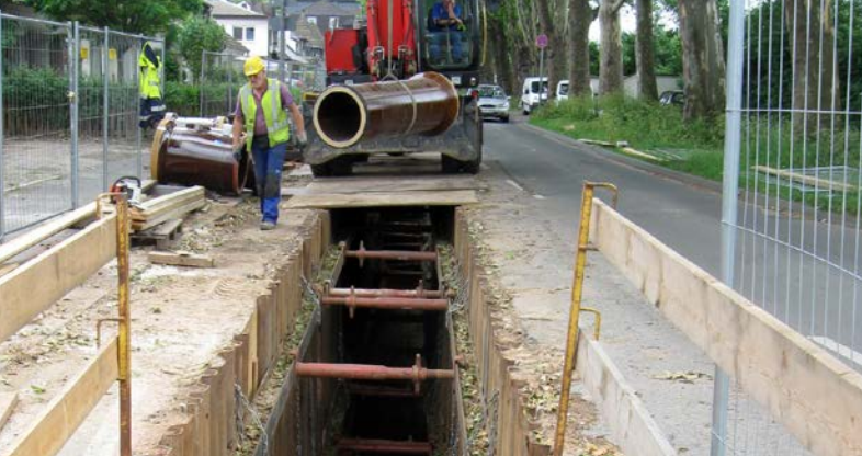
Graben ist hergestellt, und Abwasserrohre werden verlegt.
