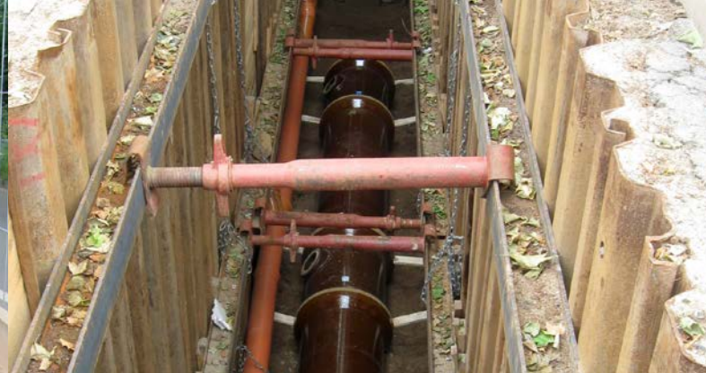
Abwasserrohre sind verlegt.
