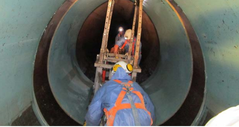
Einfahren eines Kurzrohrs mit Hilfe eines Montagewagens
