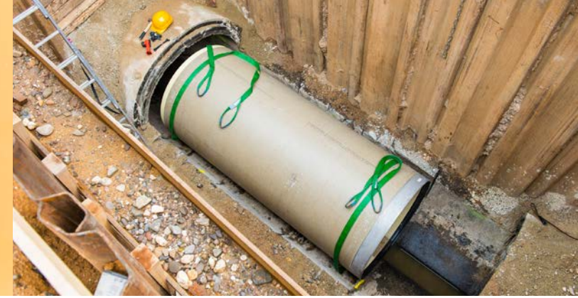
Einbringen eines Kurzrohrs über einen Montageschacht
