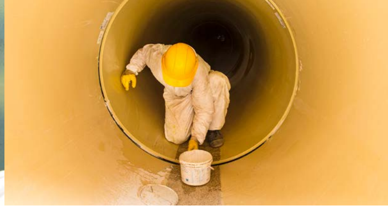
Aufbringen eines Gleitmittels zur Minimierung der Einschubkräfte
