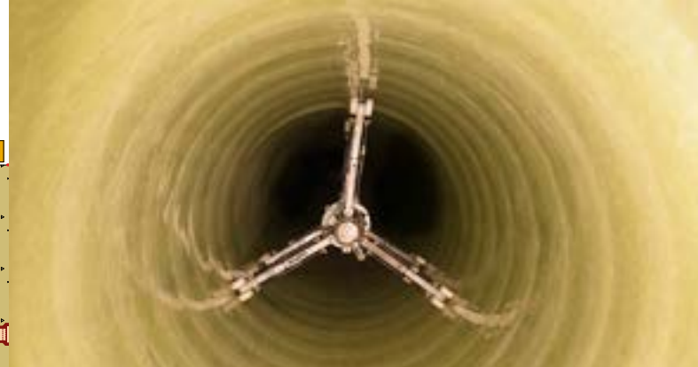
Lichterkette bei Schlauchlinieraushärtung
