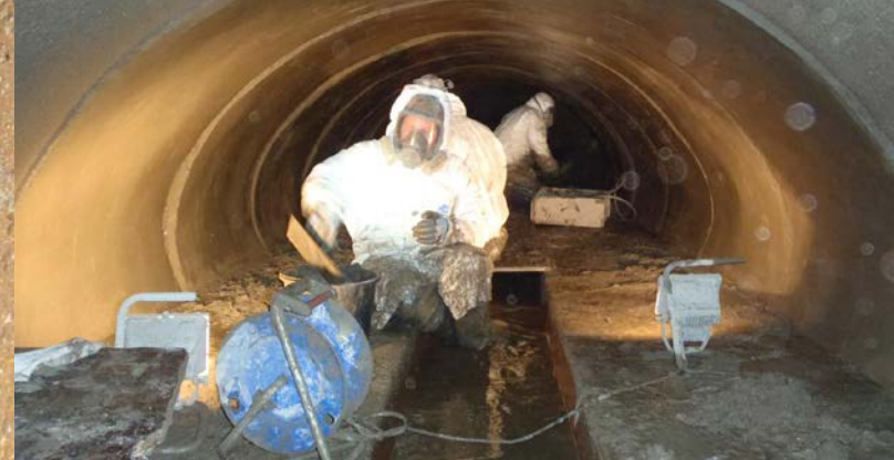
Reprofilierungsarbeiten und Fugenanierung
