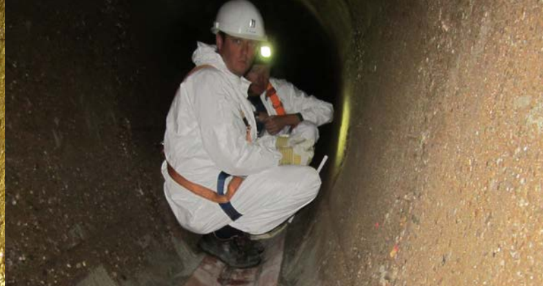
Anschlussanierung mittels kunstharzmodifiziertem Reparaturmörtel
