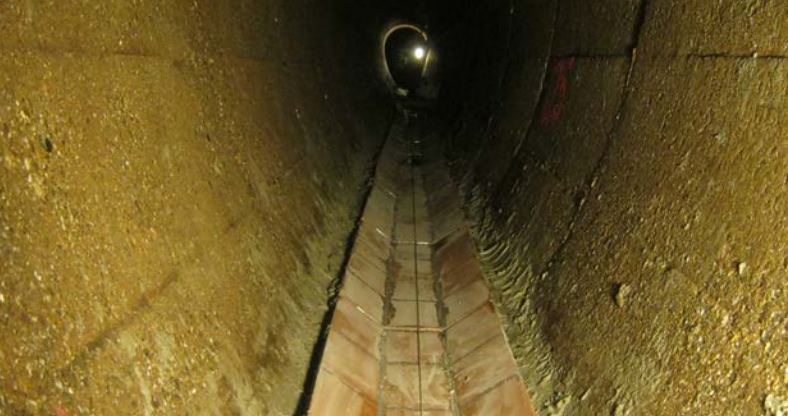
Wiederherstellung eines Sohlgerinnes mit Steinzeugplatten
