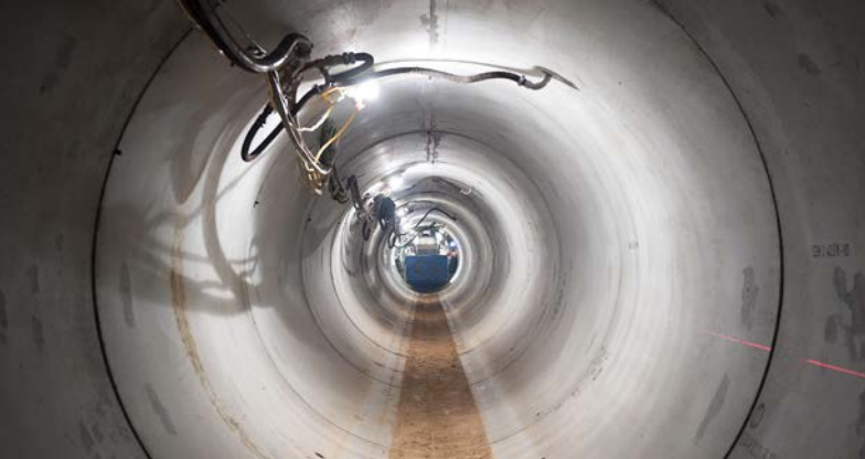
Blick in fertig verlegte Vortriebsrohre
