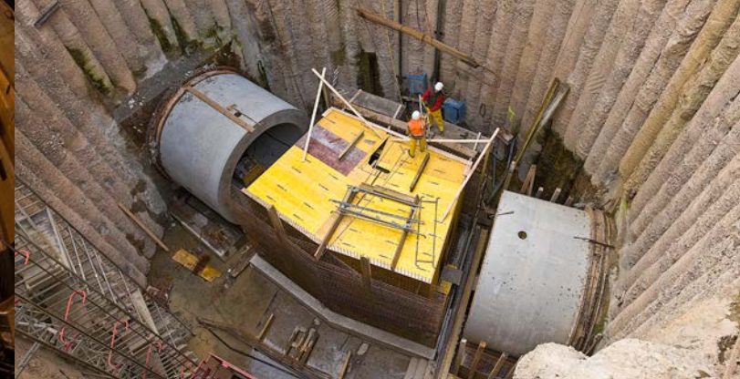
Schalungsarbeiten für Ortbetonbauwerk in Startbaugrube
