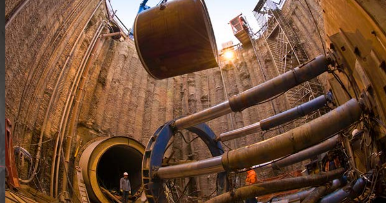
Absenken von Vortriebsrohr mit Portalkran in Startbaugrube
