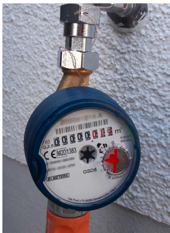
Beispiel eines Zapfhahnzählers mit Plombe
