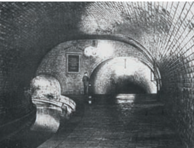
Hauptsammelkanal am Deutschen Ring mit Regenauslass, um 1900, Fotograf unbekannt
