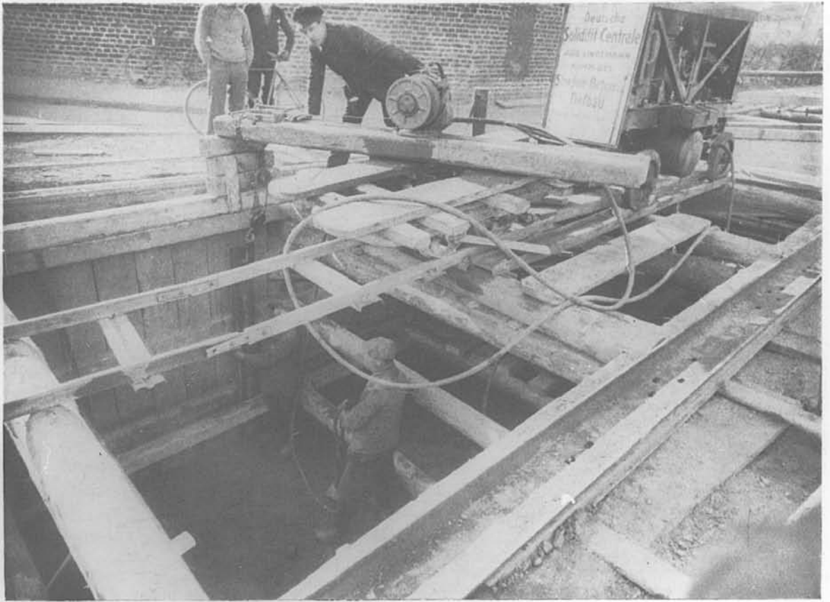
Bild 24: Ziehen der eisernen Dielen unter Luftdruck
