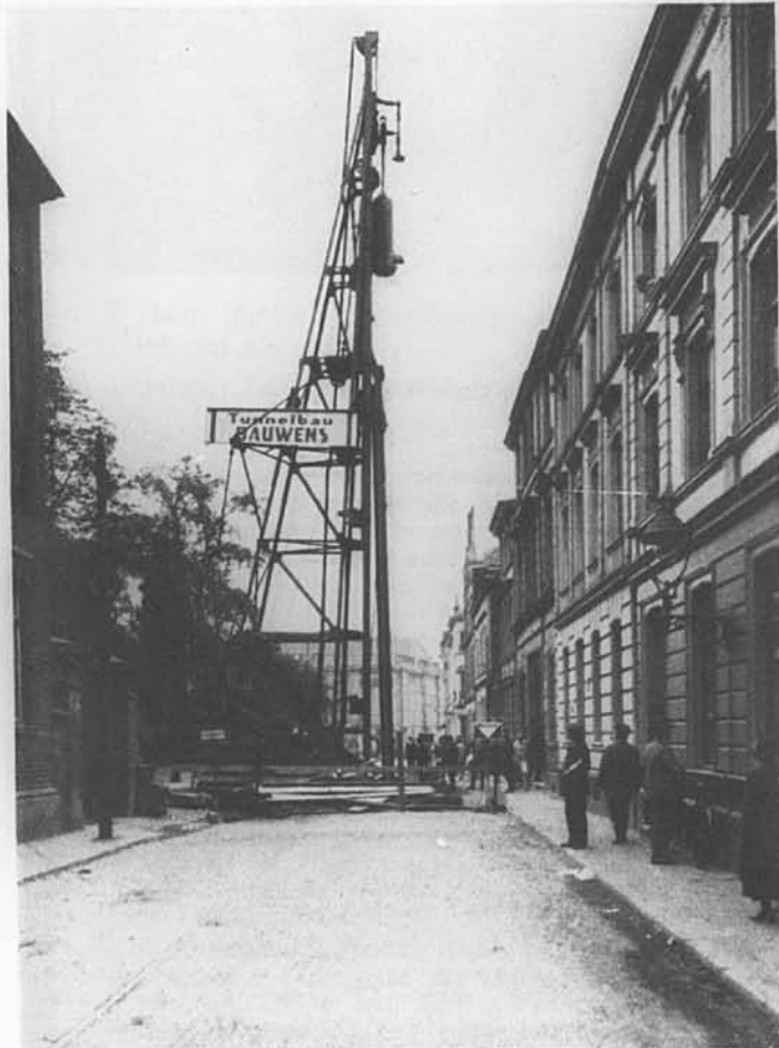
Bild 2: Rammen der Larsenwände für Förderschacht
